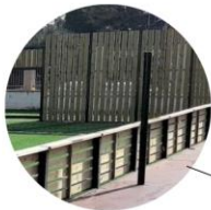
עמודים תקינים לכדורעף בקוטר 4' צול, מגולונים וצבעים בתנור.
